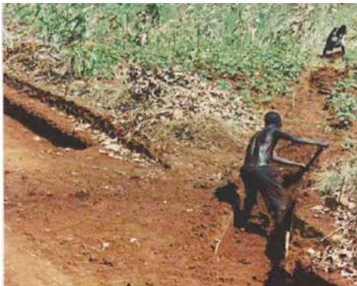
Excavating a mitre drain
