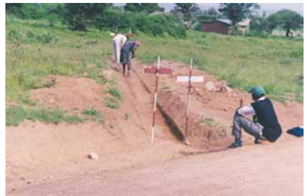
Setting out a mitre drain
